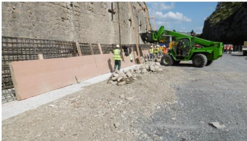
Coffrage contre-plaqué support du mur maçonné
