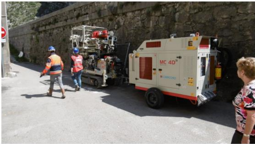
Foreuse approvisionné pour les travaux côté ville
