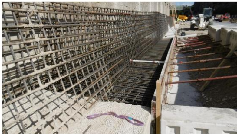
Semelle Plot N°1 bétonné
