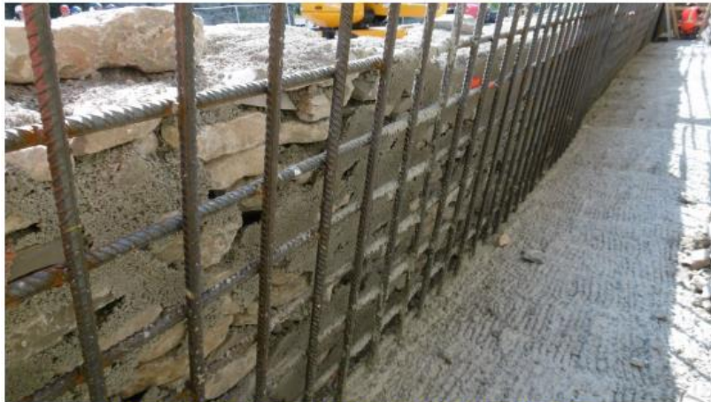
Face arrière du mur maçonné après retrait du contre-plaqué
