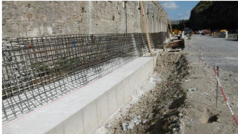
Semelle Plot N°1 bétonné
