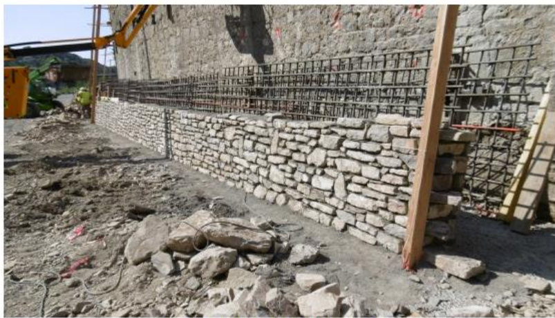
Extrémité amont de l'épaulement
