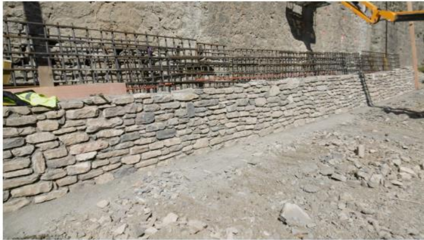
Mur maçonné en cours de construction
