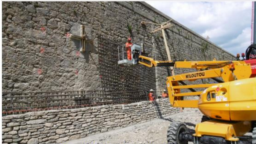
Pose du ferrailage de l'épaulement en cours
