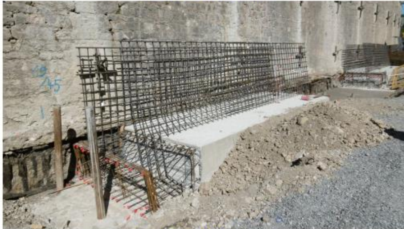
Semelle Plot N°4 bétonné
