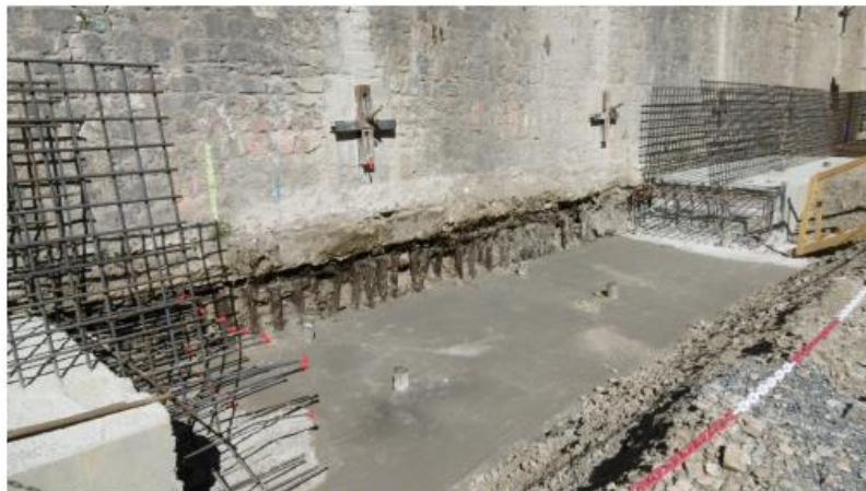
Semelle Plot N°5 – Béton de propreté
