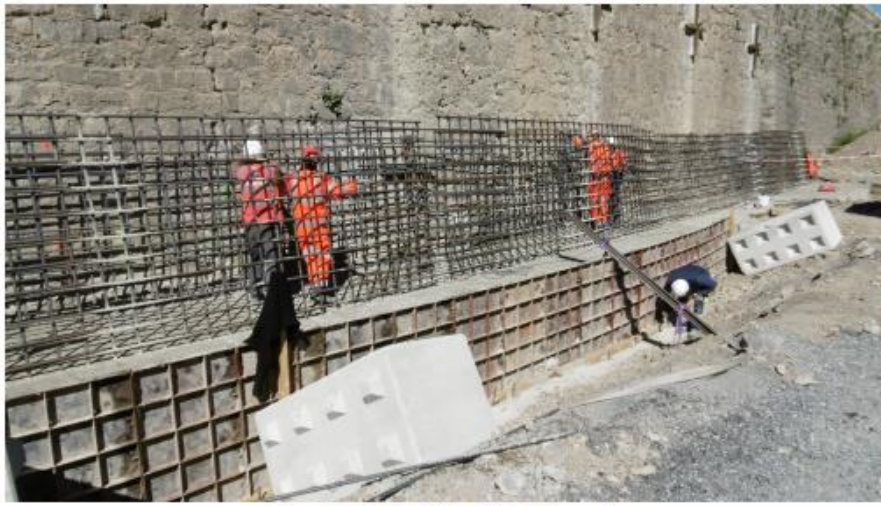
Semelle Plots N°9 et 11 bétonnés
