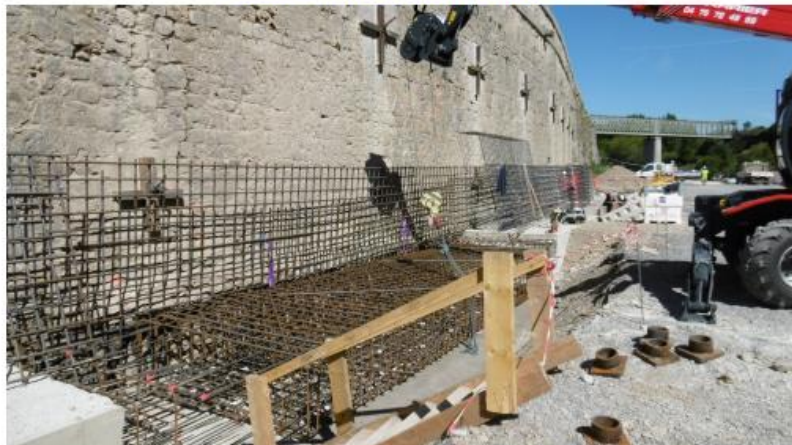
Semelle Plot N°7 en cours de ferrailage
