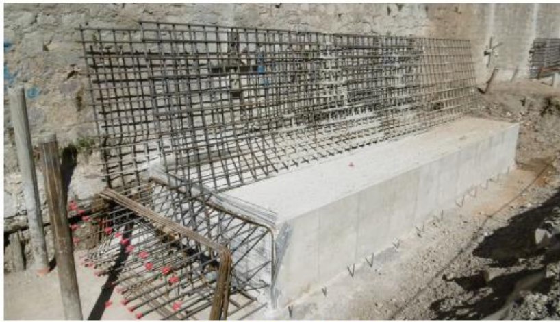
Semelle Plot N°2 bétonné
