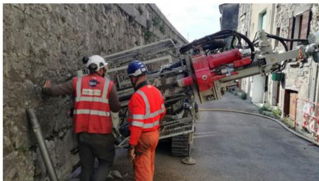
Foreuse en cours d'exécution
