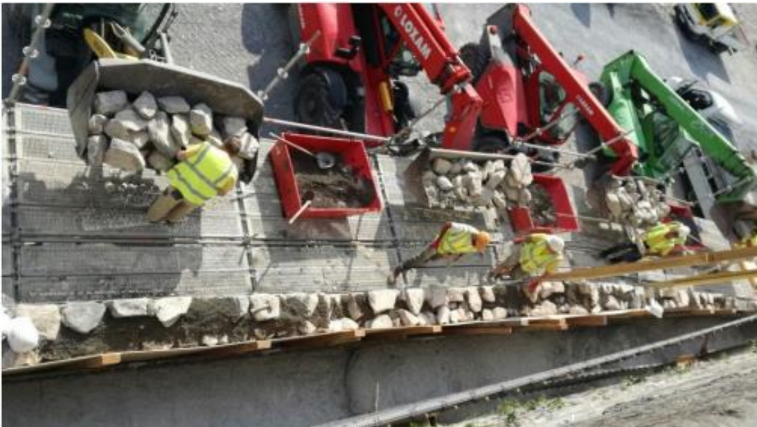
Montage de la troisième levée du mur maçonné – Secteur aval
