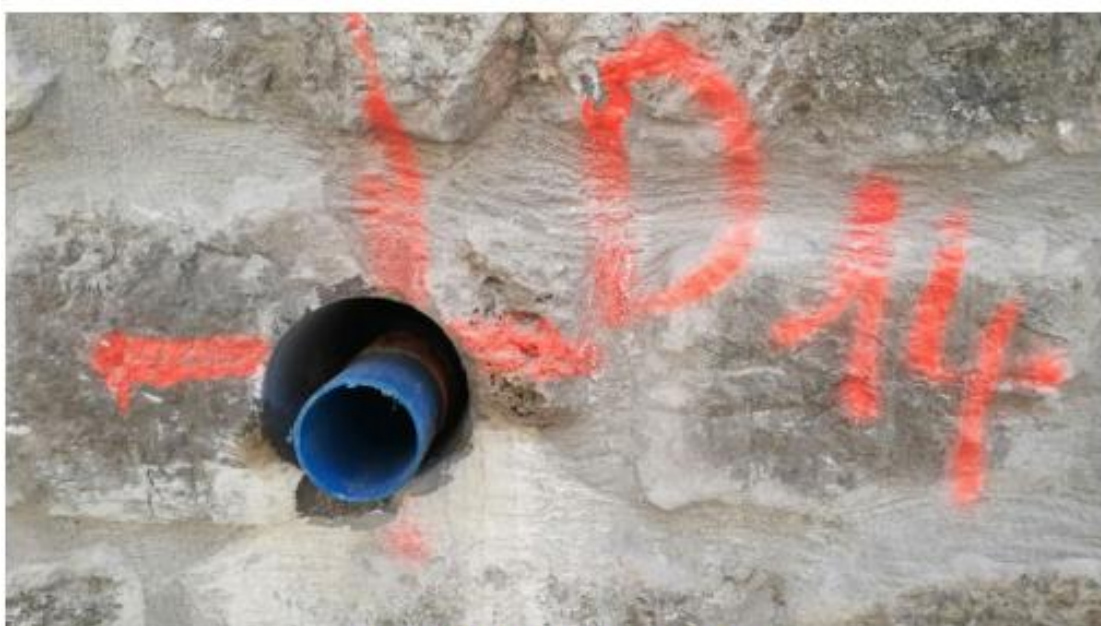
Drain D14 foré et mis en place
