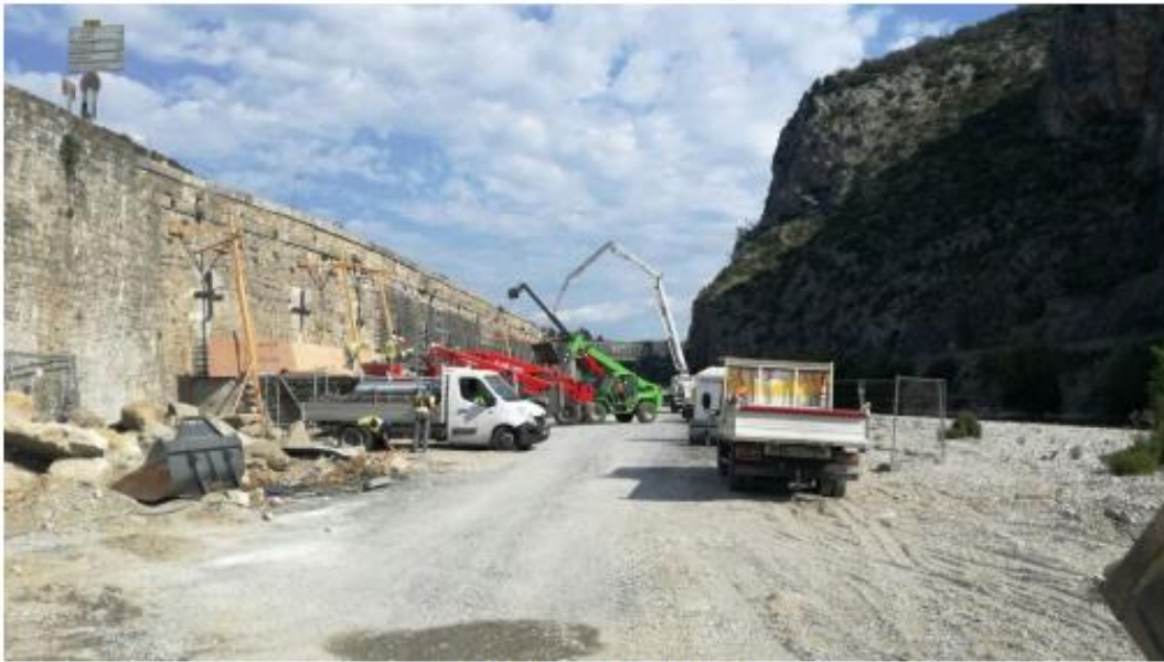
Vue de la zone de chantier
