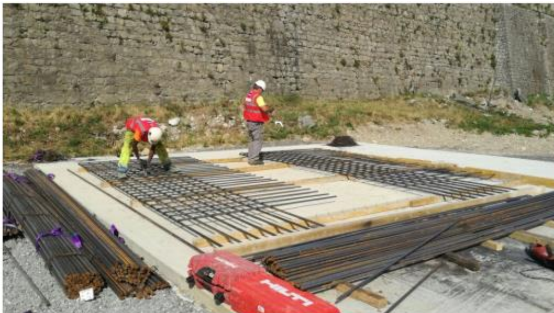
Zone de montage des aciers
